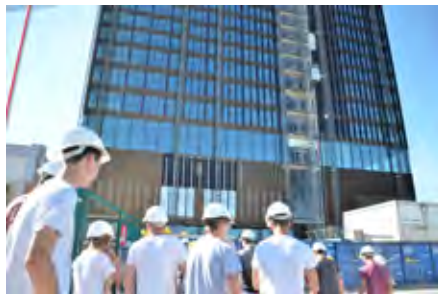
Abb. 2: Geomatik Summer School: Besichtigung des zukünftigen FHNW Campus in Muttenz.
