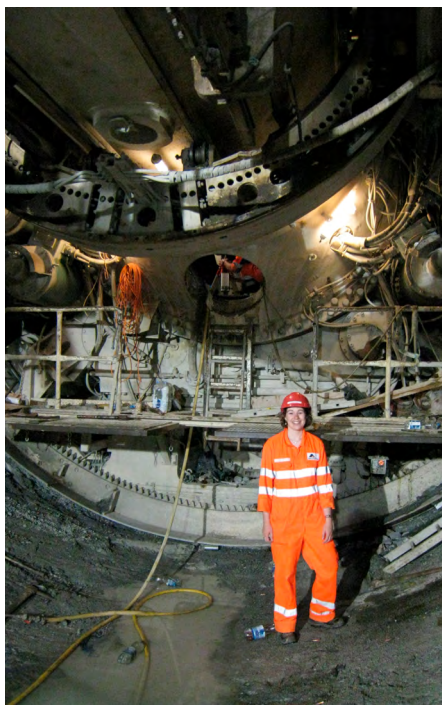
Abb. 1: Durchschlagsvermessung Erstfeld, Juni 2009.
