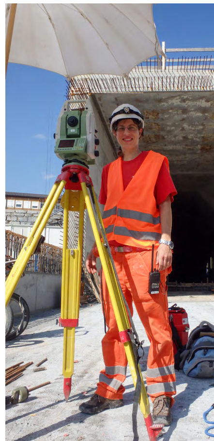
Abb. 1: AlpTransit Baustelle – Ceneri-Basistunnel, Vezia Portal, Vermessung der Haupttunnelpunkte, September 2014.
